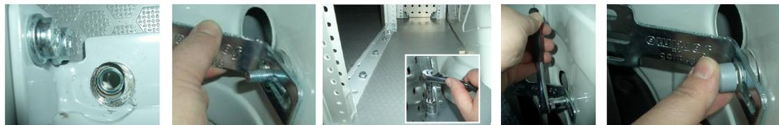
8. Blöcke an den Boden- und Wandbefestigungspunkten ausrichten
